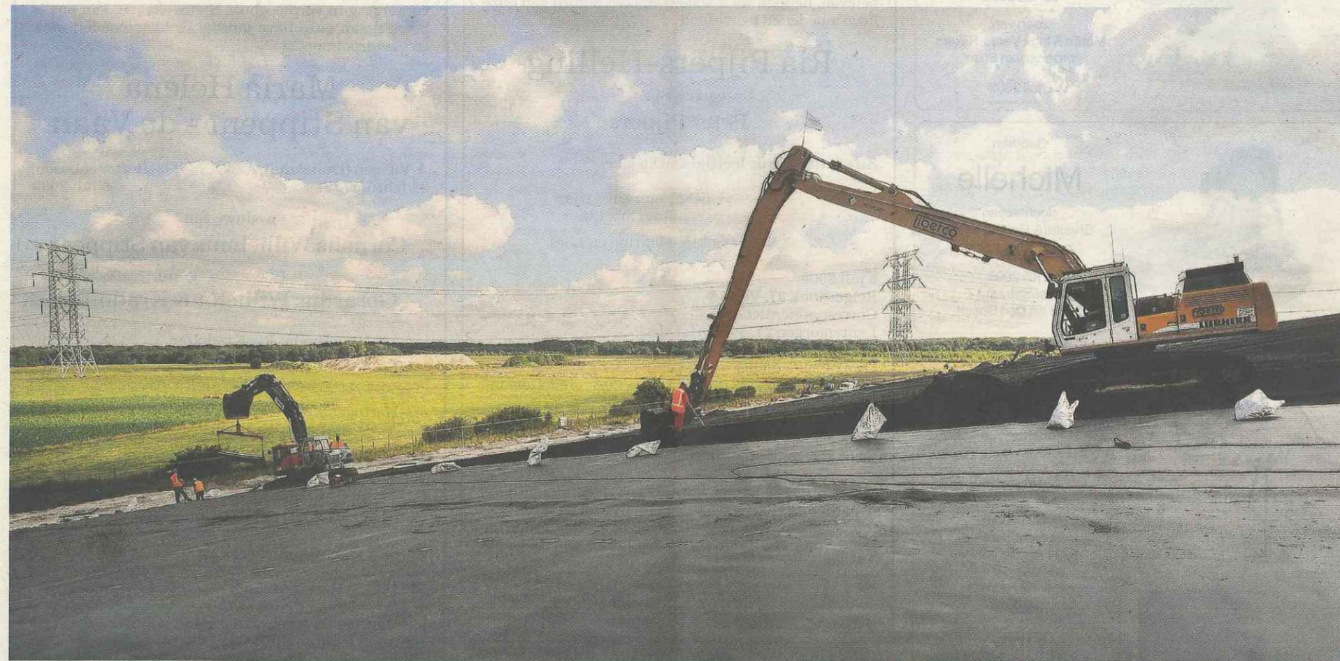
Het Trisoplast wordt afgedekt met plastic folie. daarop komt nog drainagefolie, gevuld door schone grond.
