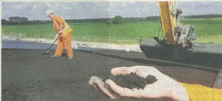
Trisoplast is in dit geval zwart van kleur, vanwege het vormzand.
